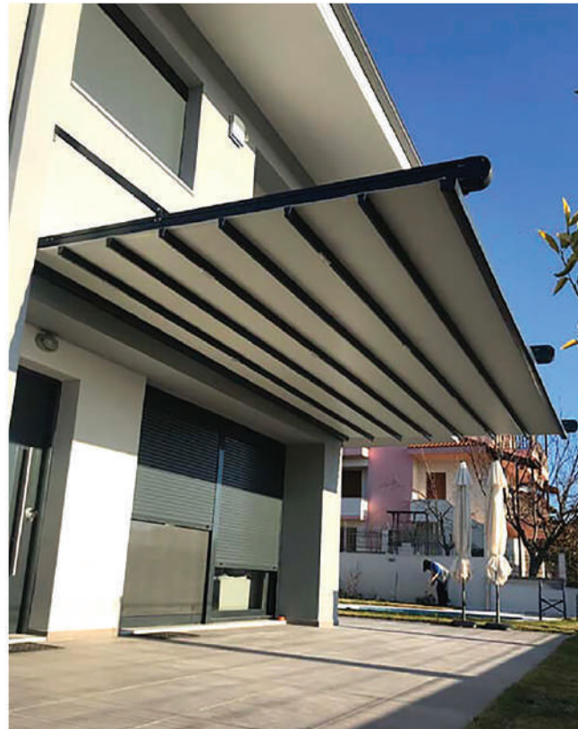
Εναέρια κατασκευή πτυσσόμενη
